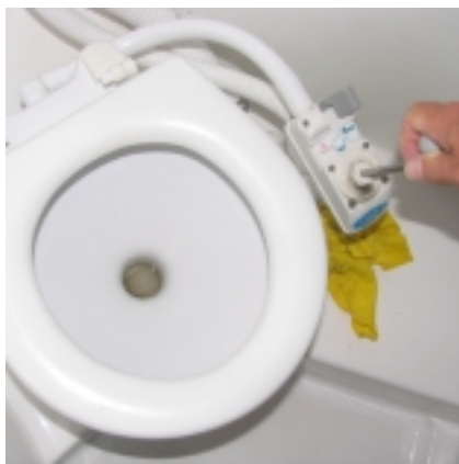
Toilet goed leegpompen
