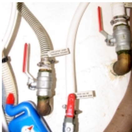
Alle afsluiters open bij het doorspoelen
