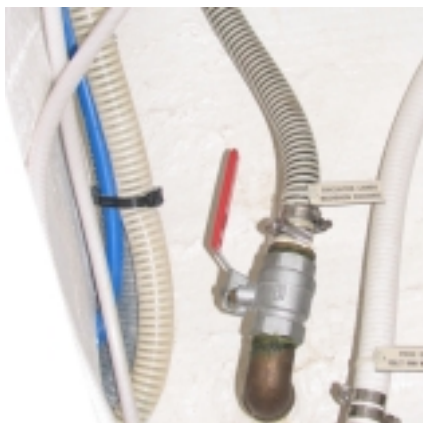
Afvoerkraan openen en legen
