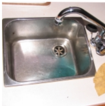
Antivries in de afvoer
