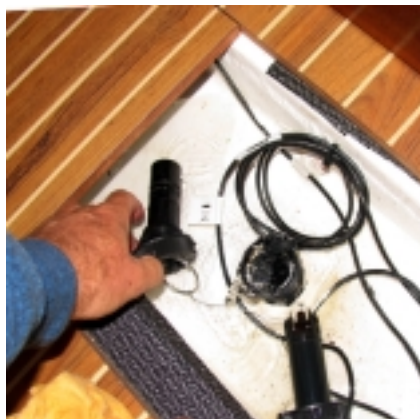
De log verwijderd, water stroomt binnen
