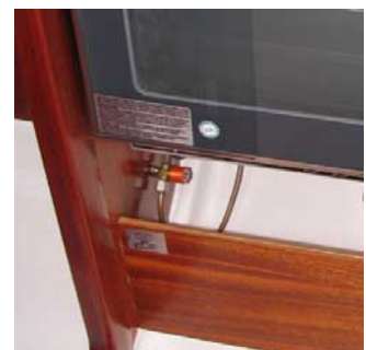
Afsluiter links onder het fornuis
