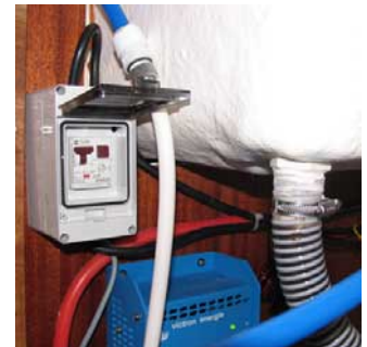
De Aardlekschakelaar in het spiegelcompartiment
