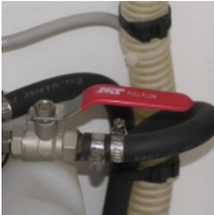
Brandstofkraan geopend
