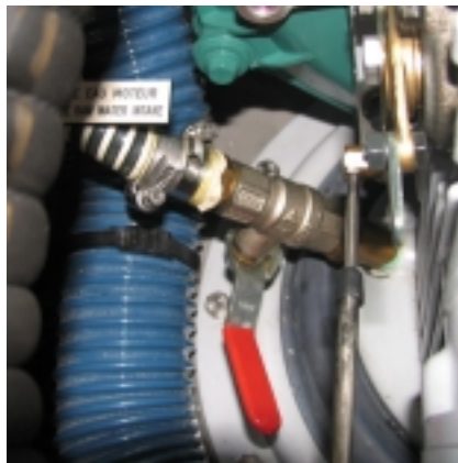
De koelwatertoevoerkraan
